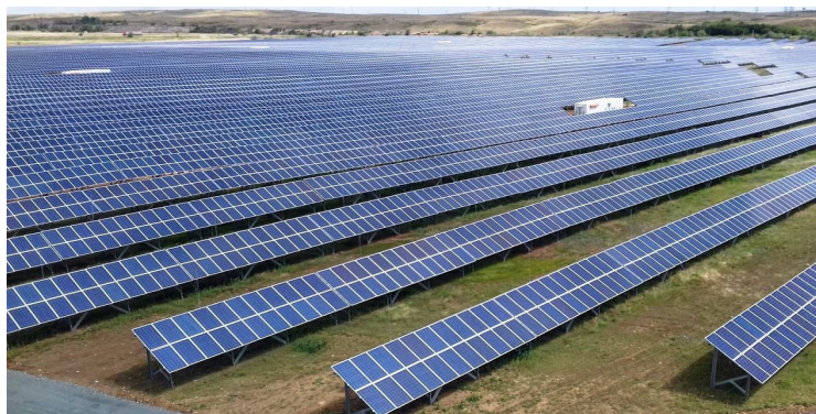
Рисунок 3 – Общий вид площадки СЭС в городе Сарань
