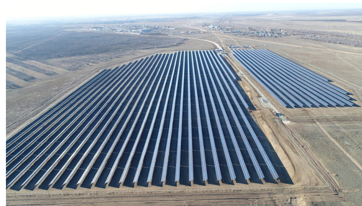
Рисунок 2 – Капчагайская солнечная электростанция
