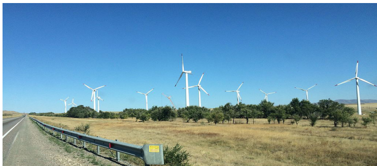
Рисунок 1 – Кордайская ветровая электростанция
